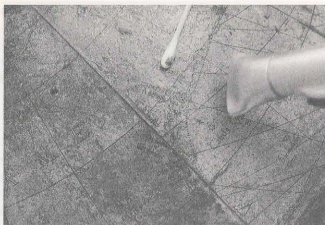
12. Het werken met het damp-apparaat. Hiermee werd de sterk vervuilde lijmlaag die zich onder het vernis bevond verwijderd. Tegelijkertijd werden zo de blazen die op verschillende plaatsen in het papier voorkwamen glad gemaakt.
